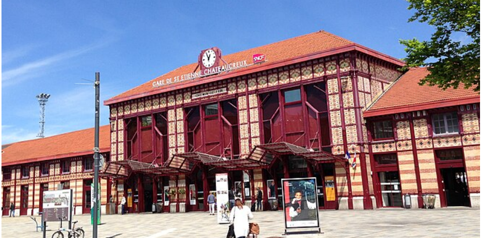
Estación de Saint- Étienne. Francia 46 .
